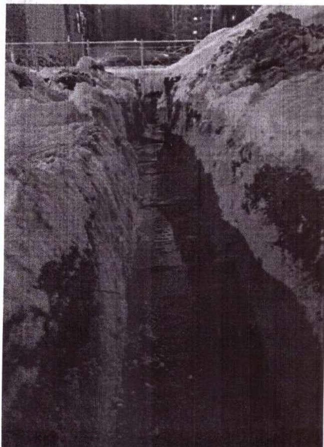
5. Строительство ЛЭП-0,4 кВ для электроснабжения электронного экрана по ул. Прибалтийская в г. Когалым (ЛЭП-0,4 кВ ориентировочной протяженностью 0,135 км).
